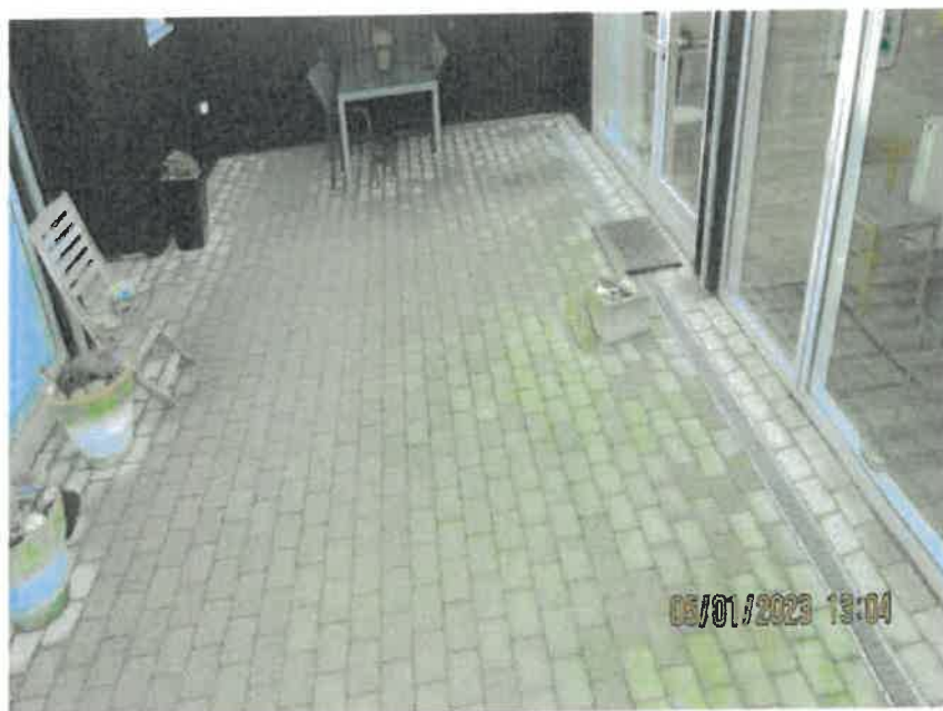
Belægningssten i solgårde.
