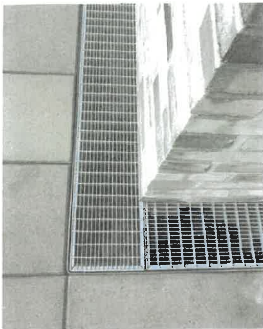
Færdige hjørneprofiler sikrer nem montage uden tilskæringer Søjlen støbt i god kvalitet
