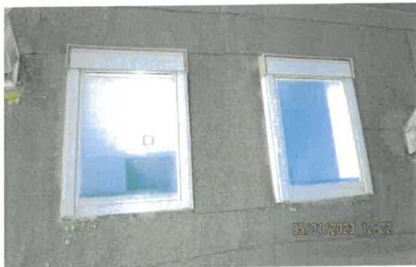
Ovenlysvinduer i tagflade.
