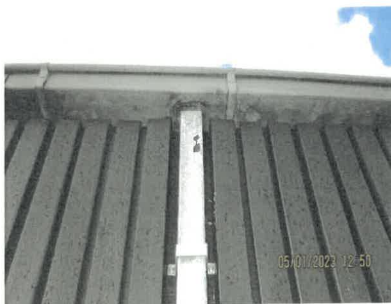
Zinktagrende med tilhørende nedløbsrør i zink.
