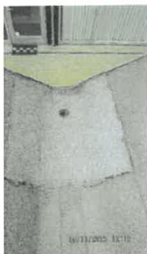
Ny tagbrønd udført i rustfrit stål
