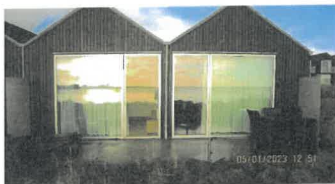
Vinduer/terrassedøre i sydfacade.
